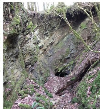
Tranchée et tunnel, dans un méandre du cours d'eau, pour béal d'irrigation (Vabre)
