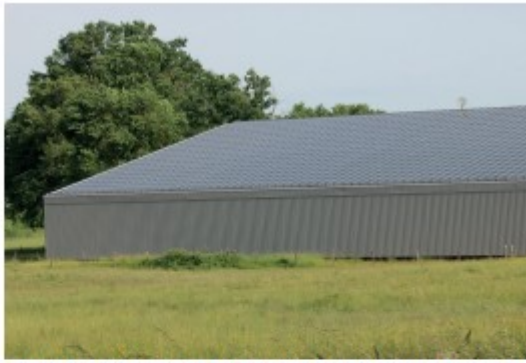
Unité de teintes et continuité entre les panneaux photovoltaïques et le bardage métallique gris
