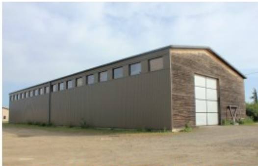
Unité de teintes dans un environnement de couleur beige/marron - ici bardage bois et métallique
